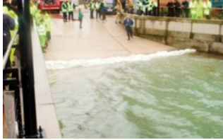
FloodSax-Kissen mit wasserabsorbierenden Innenpads
